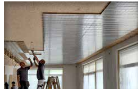
Deckenheizung auf OSB Untergrund
