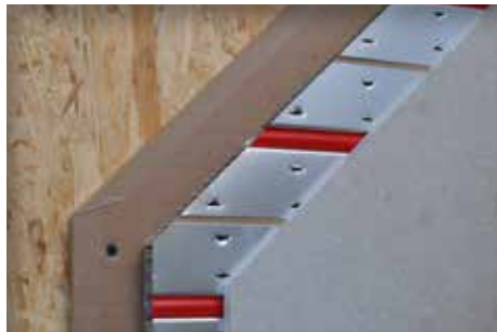
Wandheizung auf OSB und PhoneStar
