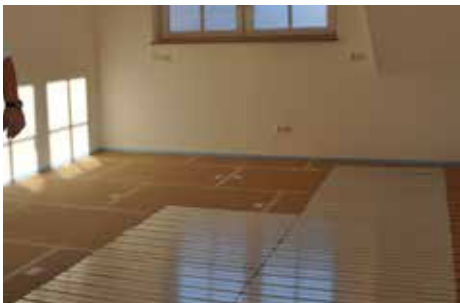
Fußbodenheizung Montage auf PhoneStar
