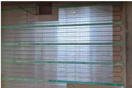
Wandheizung Montage zwischen Lattung
